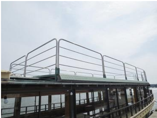
屋上展望スカイデッキ
